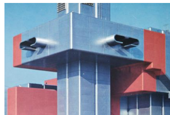
データセンター
